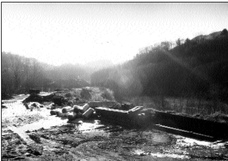
Piana di Zegori (SP) - I lavori di costruzione della nuova strada.
